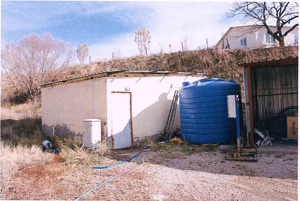
Fotoğraf 20. Maden İşletmesi Artırma Tesisi
