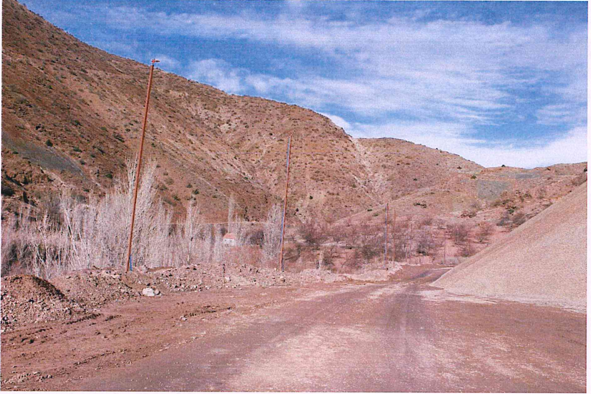
Fotoğraf 18. Güvenç Kırma ve Eleme Tesisi - Sulama Sistemi
