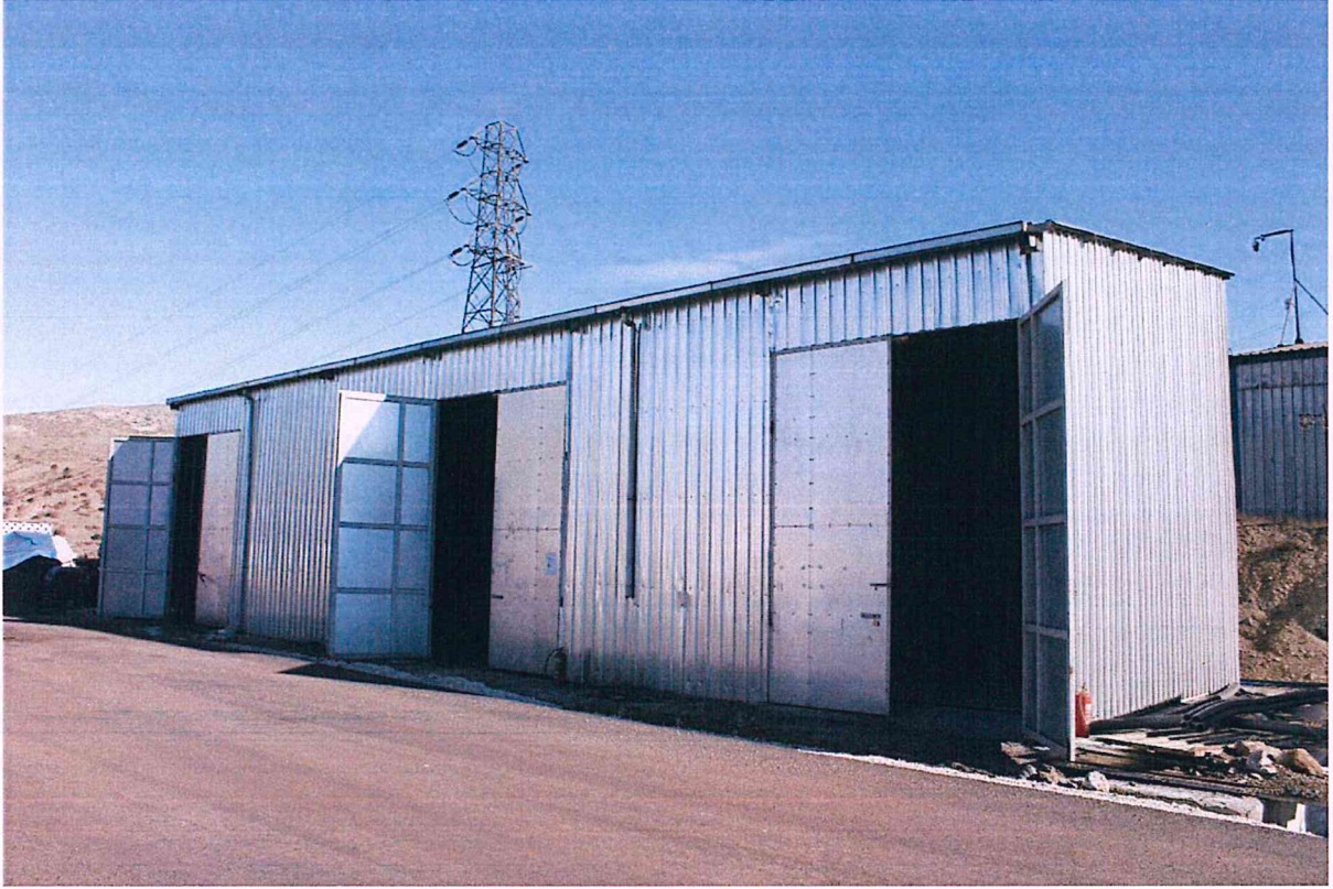
Şekil 43. Fabrika İşletmesi Tehlikeli-Tehlikesiz Atık Geçici Depolama Alanı
