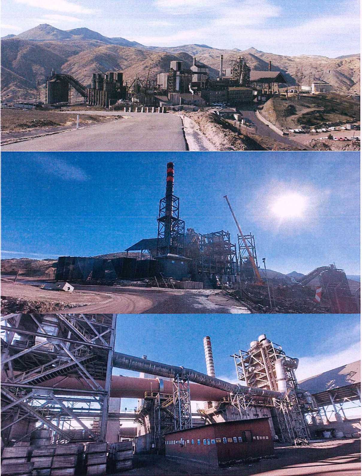
Fotoğraf 4. Hekimhan Siderit Kalsinasyon Tesisi Genel Görünümler- 2 (19.12.2023)
