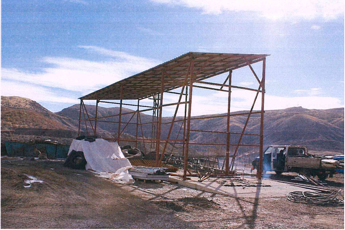
Şekil 45. Maden İşletmesi Tehlikesiz Atık Geçici Depolama Alanı
