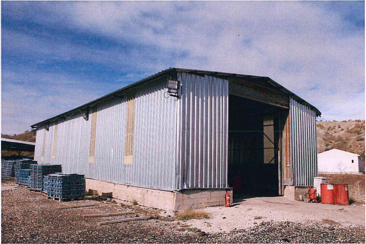
Şekil 44. Maden İşletmesi Tehlikeli Atık Geçici Depolama Alanı
