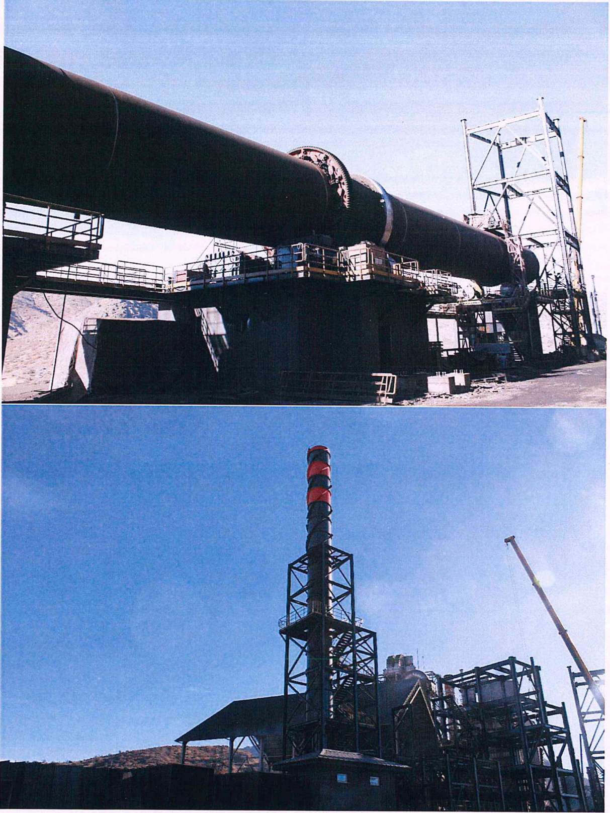
Fotoğraf 7. Hekimhan Siderit Kalsinasyon Tesisi Genel Görünümler- 5 (19.12.2023)
