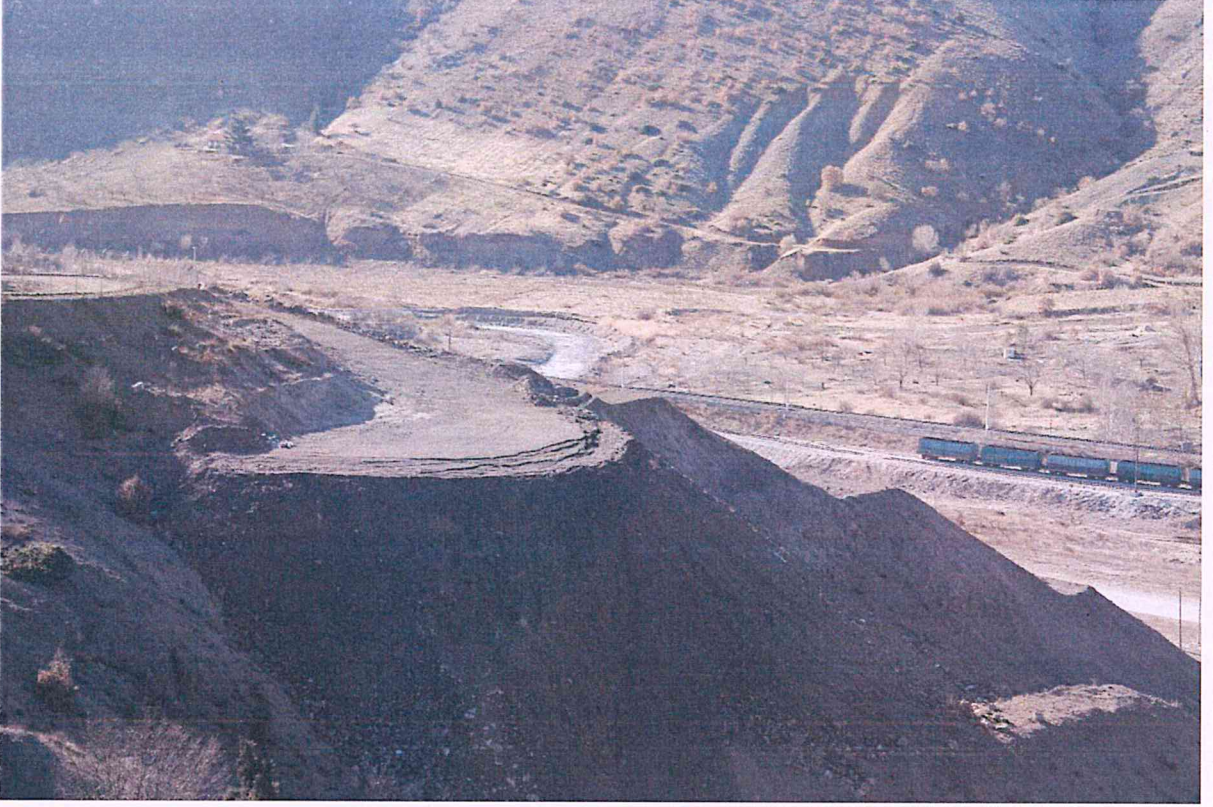
Fotoğraf 10. Hekimhan Kalsinasyon Tesisinden Ulu Dere (1)
